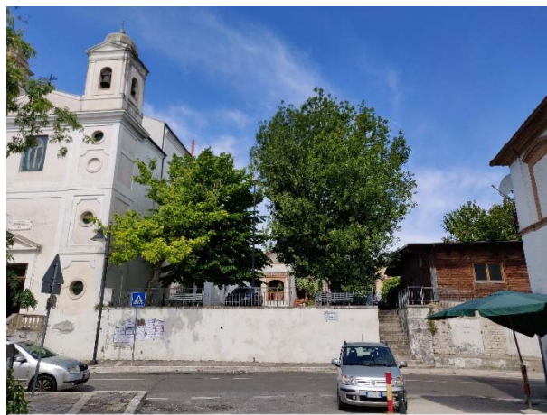
Figura 3. Lato est, Strada Provinciale
