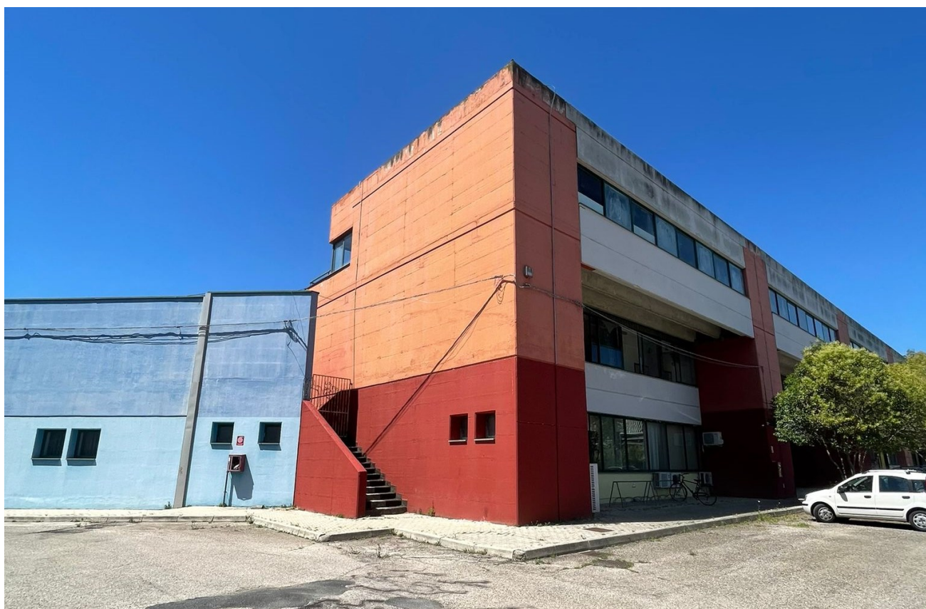
Fianco Nord dell'edificio esistente
